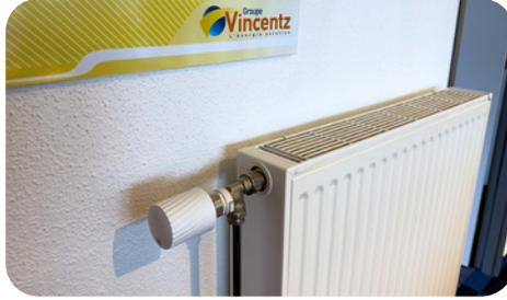
Sanolec a équipé les radiateurs de notre site de Niederhergheim de têtes thermostatiques connectées via le protocole LORA. Reliées à notre système de supervision, elles permettent de contrôler en temps réel la consommation d'énergie, optimisant l'usage du chauffage. Ce projet, soutenu par les certificats d'économie d'énergie (CEE), allie performance énergétique et réduction durable des coûts.
