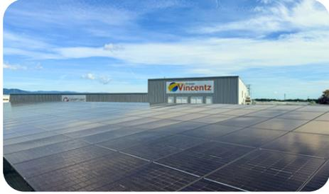
Noé et Electricité Vincentz ont installé, cet été, une ombrière photovoltaïque de 600 m<sup>2</sup> sur le parking avant du site de Niederhergheim. Équipée de 312 panneaux photovoltaïques, l'installation est soutenue par deux onduleurs de 50 kW. En plus de sa contribution à la production d'énergie verte, l'ombrière comprend six bornes de charge rapide de 22 kW, dont deux sont accessibles au public, ainsi qu'une prise dédiée aux vélos électriques.
